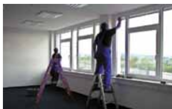
Endreinigung der Glasflächen
