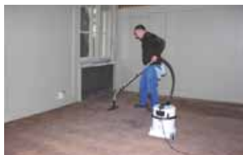
Feinreinigung nach Restaurierung
