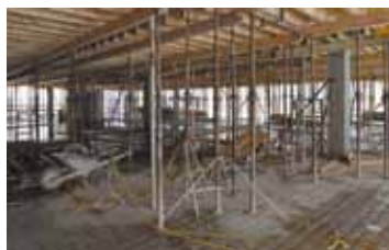
Grobreinigung in einem Neubau
