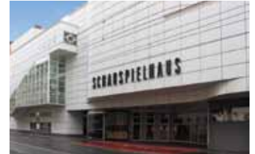
Schauspielhaus Hannover Regelmäßige Fassadenreinigung
